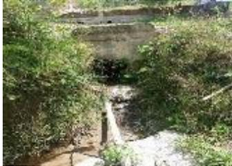
Se realizó visita técnica a la Vereda Sabanitas para revisión del daño que se está ocasionando por el mal manejo de unas aguas lluvias de la carretera principal. Al momento del recorrido se pudo ingresar hasta el sector solicitado, encontrando la socavación lateral de los taludes de la vía que conduce a la finca San Jorge, esto se está dando por las aguas de la parte alta de la vereda, ya que no se están tratando de forma adecuada.
