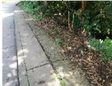
Se hace revisión de un andén el cuál sus placas se encuentran levantadas y agrietadas esto está siendo generado al parecer por la inestabilidad del talud por sus suelos desnudos, por la presión
