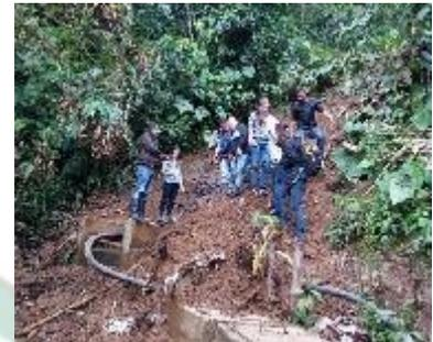
Al momento del recorrido se pudo llegar hasta donde se encuentran construidos los diferentes tanques, los cuales se les hace una inspección con el Ingeniero constructor, se evidencia que se encuentra trabajando normalmente, se observa el mal mantenimiento del mismo, es importante aclarar que se encuentra rebozando el agua sobrante y está vertiendo directo hacia un talud con una pendiente muy fuerte, generando socavación y posibles deslizamientos en la zona
